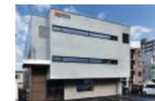
高断熱化と高性能ガラスの採用によりエネルギー負荷を低減し、高効率設備の導入により、高い省エネルギー性を実現。一次エネルギー消費量56%削減。自立発電機能を発揮する電源自立型GHPの導入により、災害時にも業務継続可能なレジリエンス強化型ZEBを達成。
