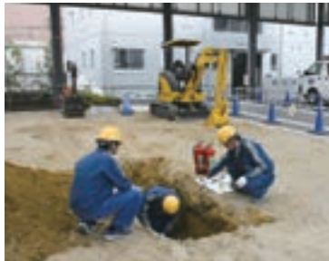
掘削を伴うガスもれ修理実習フィールド
