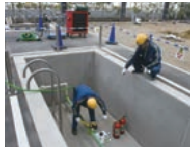
埋設配管のガスもれ修理実習ができる屋外ピット
