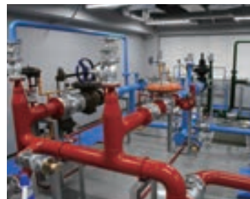
ガバナ（整圧器）の運転・停止や整備の技能を習得
