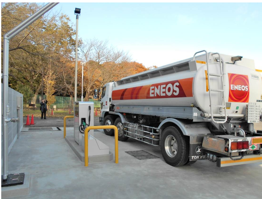
建設した自家用給油所。稼働に向けてタンクローリーからの充填作業を行う＝12月8日
